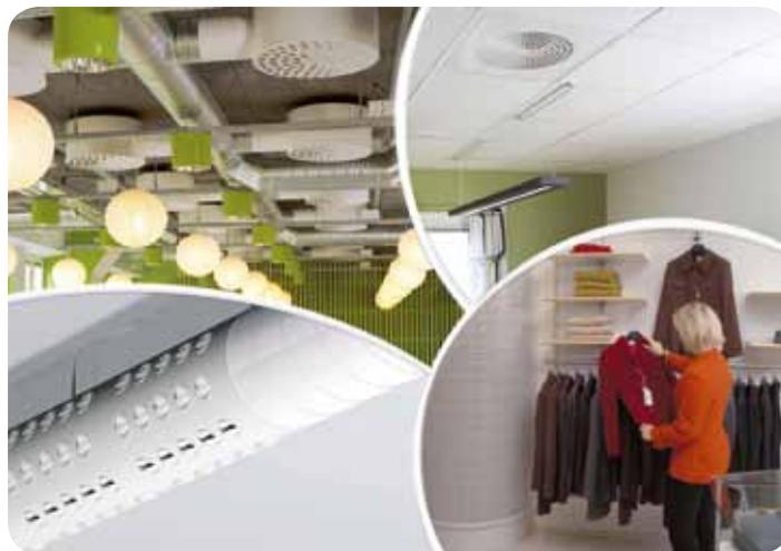
Различные модели дисковых диффузоров - круглые, прямоугольные, встроенные и подвешенные, для монтажа в воздуховод и многие другие
